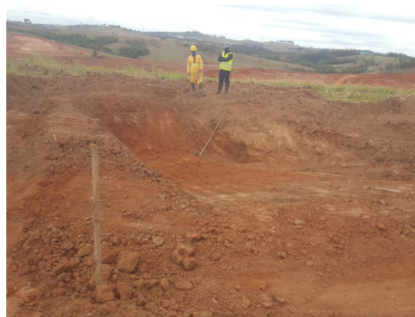
Foto 2: Estruturas no Canteiro Industrial (lavador de bicas, ainda sem a proteção) (22/09/2020)
