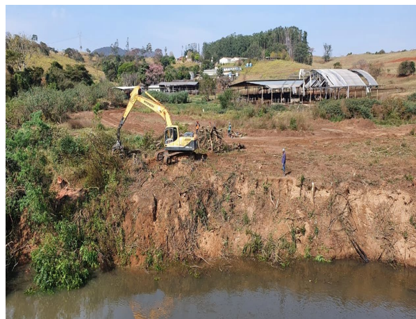
Foto 17: Acompanhamento da atividade de supressão - 19/08/2020
