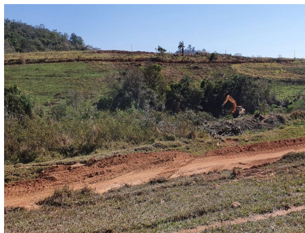
Foto 19: Acompanhamento da atividade de supressão - 21/08/2020
