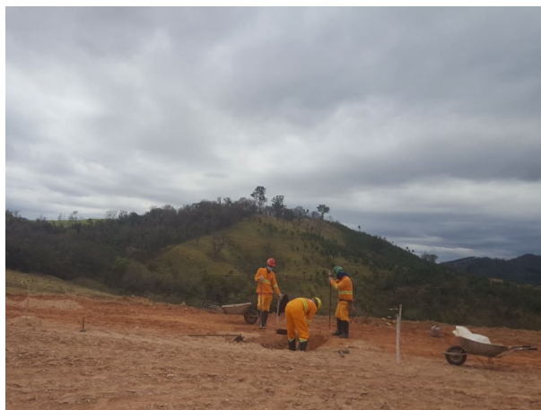
Foto 1: início da Construção das estruturas do Canteiro Industrial (21/09/2020)
