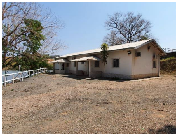
Foto 5: Estruturas do Canteiro Administrativo (26/08/2020)
