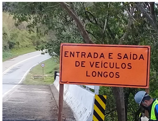
Foto 14: Instalação de placas de sinalização (22/08/2020)
