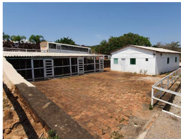
Foto 6: Estruturas do Canteiro Administrativo (26/08/2020)
