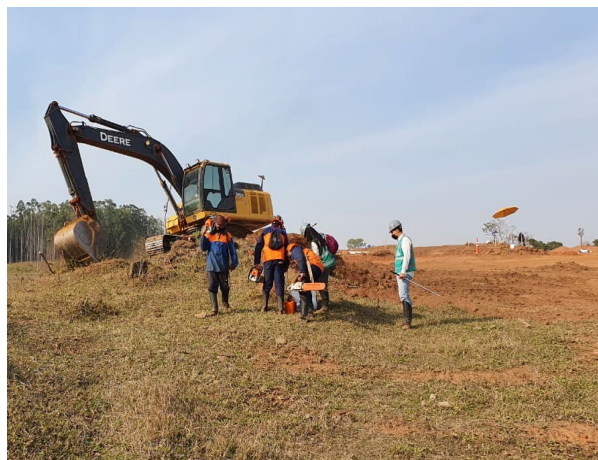
Foto 21: Acompanhamento da atividade de supressão – 10/09/2020
