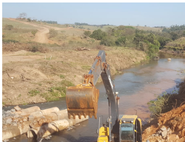
Foto 12: Construção da passagem molhada (01/09/2020)
