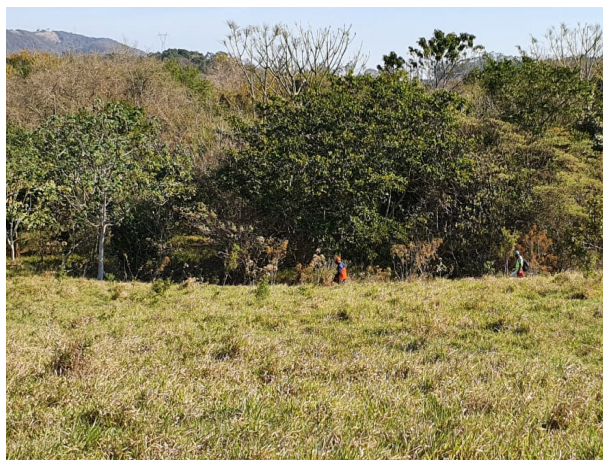
Foto 20: Acompanhamento da atividade de supressão – 01/09/2020
