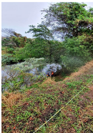
Foto 16: Acompanhamento da atividade de supressão – 17/08/2020
